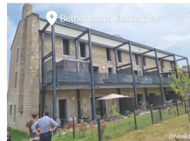
Réhabilitation performante et innovante d'une ancienne église
